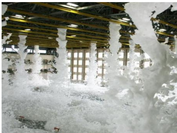
Рис. 8. Работа пенной АУПТ
