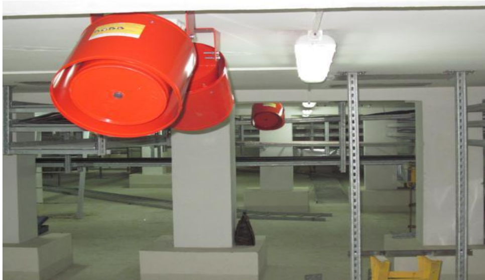
Рис. 11. Генератор огнетушащего аэрозоля «ТОР-3000»
