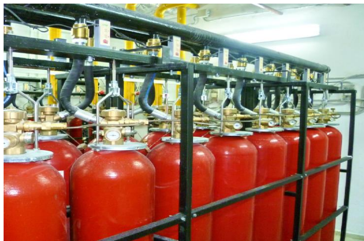
Рис. 9. Модуль газовой АУПТ
